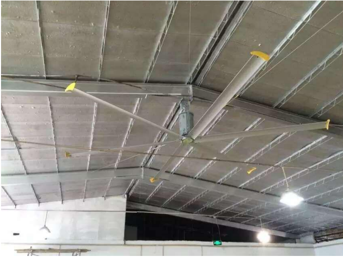
白雲電器車間大吊扇安裝案例
