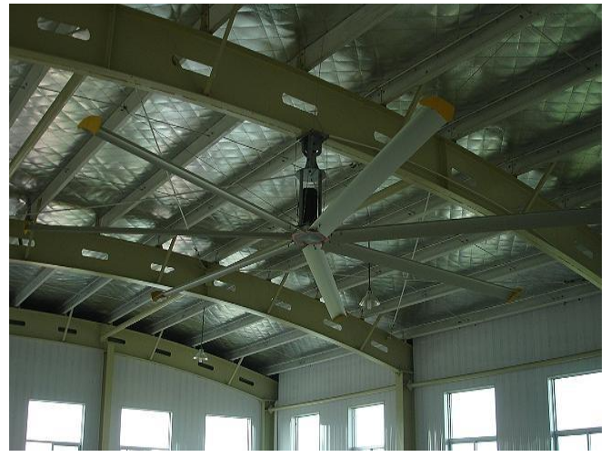
三隻松鼠倉儲大吊扇安裝案例
